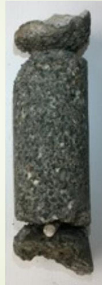
Fissures latérales et barre d'armature corrodée de la CR-5
