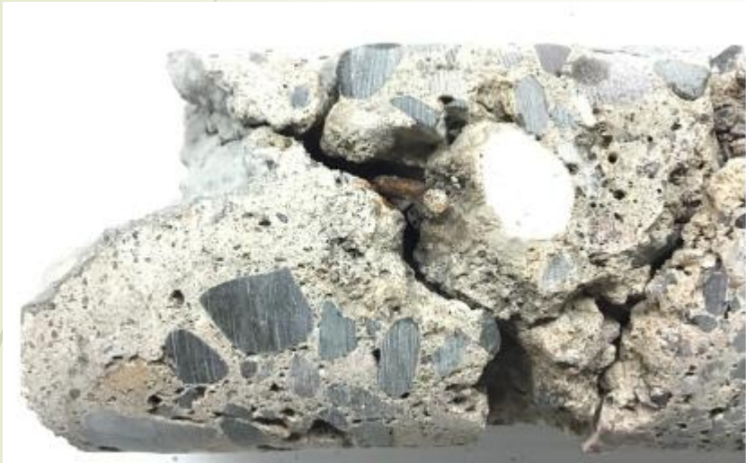
Réseau de fissures dans la CR-8
